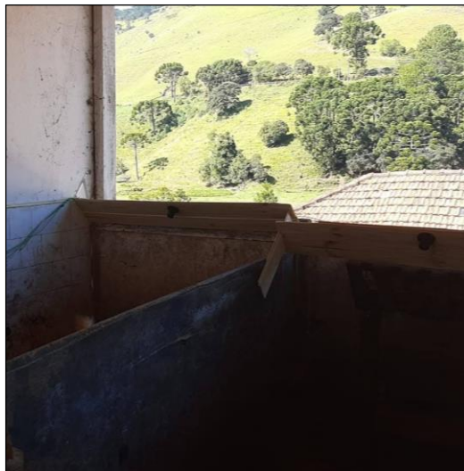
Figura 3: Construção do protótipo Fonte: As autoras.
