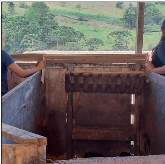
Figura 2: Construção do protótipo Fonte: As autoras.
